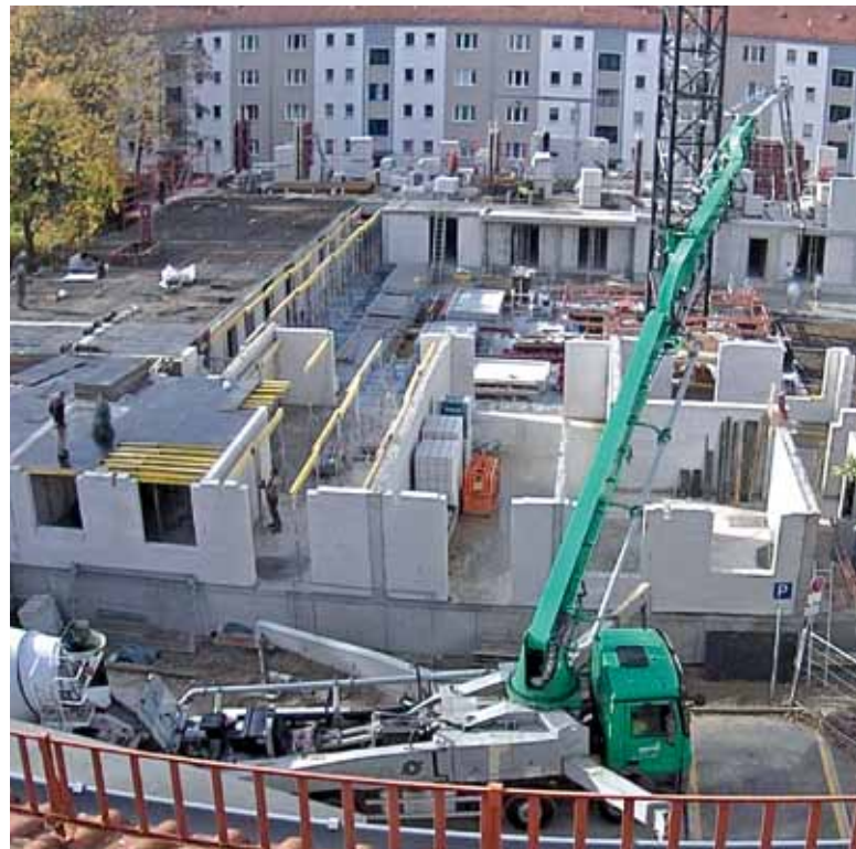
Stand der Bauarbeiten – Webcam 27. Oktober 2022
