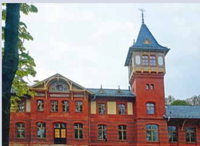
Die Fassade vom frisch sanierten „Eierhäuschen“ im März 2022
