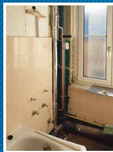
Strangsanierung in der Hans-Thoma-Straße 7–11
