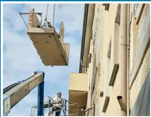
Abbruch der alten Balkone in der Leiblstraße 17–18a
