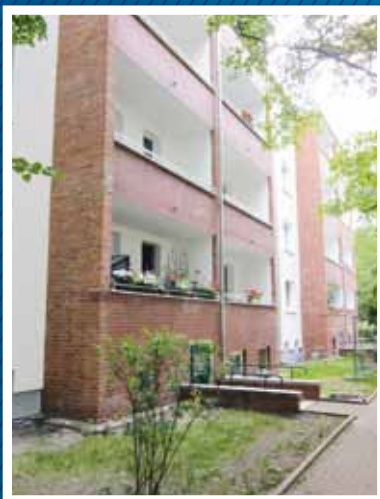
Fassadendämmung in der Köpenicker Landstraße 156–158
