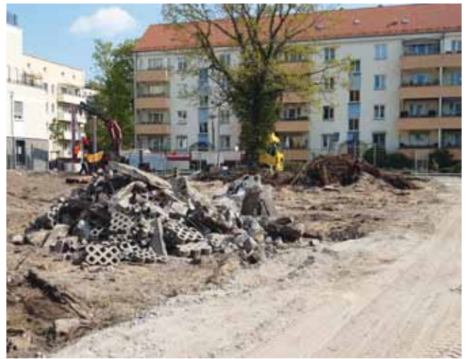
Freimachung des Geländes
