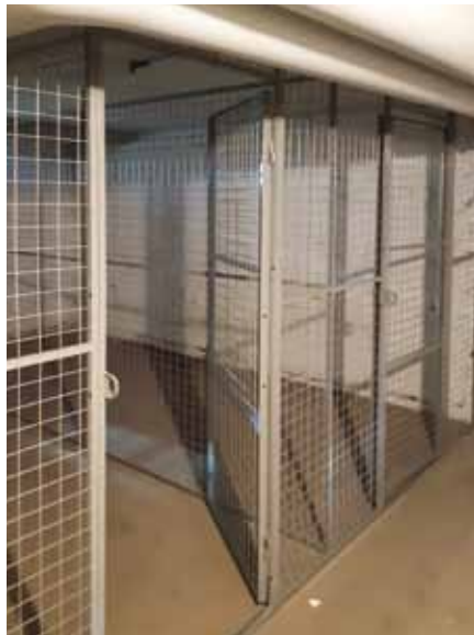
Keller nach der Brandschadensanierung
