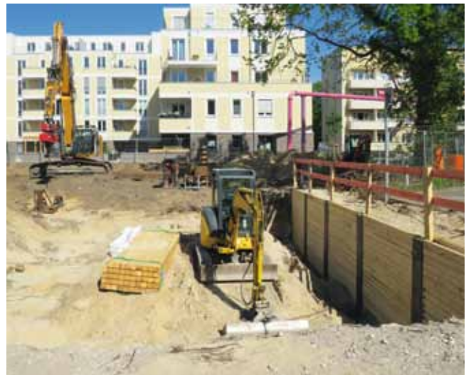
Verbau des Neubaus EichbuschKarree
