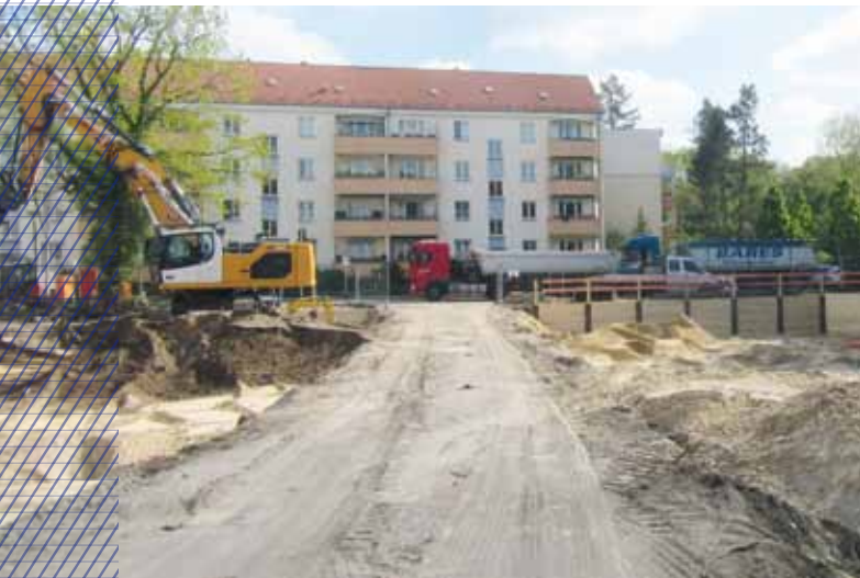
Baustraße im Baufeld
