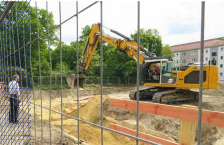
Erdarbeiten in der Baugrube
