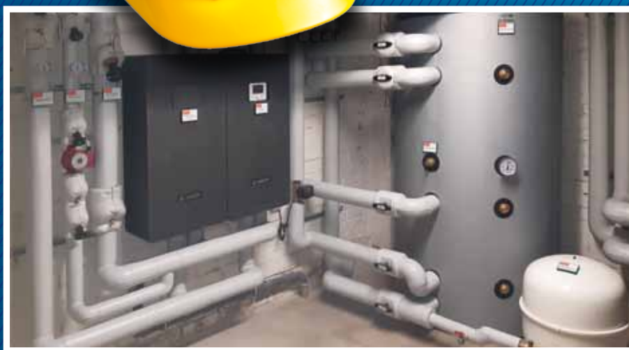
Neue Heizung in der Frauenlobstraße
