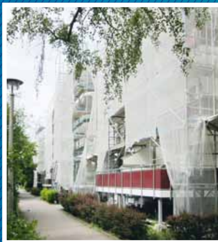
Fassadendämmung in der Kieffholzstraße 163–164a
