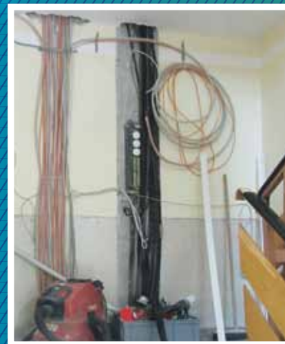
Verlegung neuer Elektrosteigleitungen in der Lohmühlenstraße 49–52
