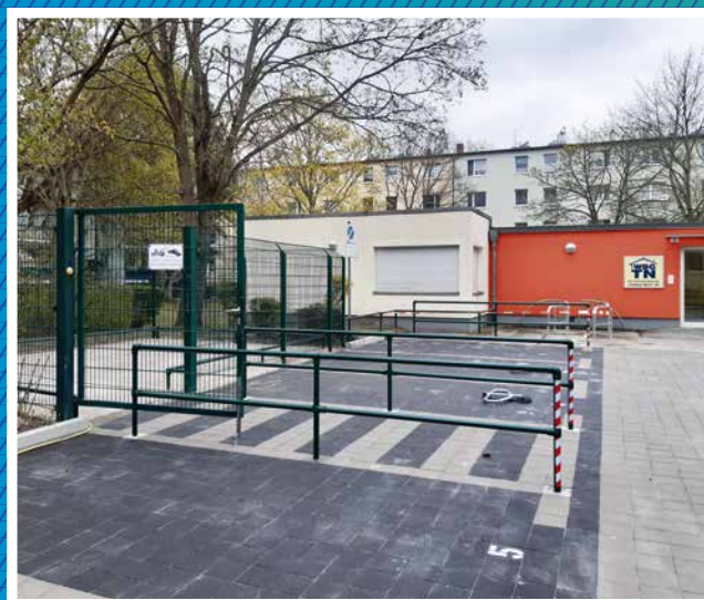
Kieholzstraße 159: Anlegung neuer Flächen für Pkw, Fahrräder und den Müllstandsplatz.
