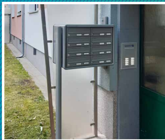
Neue Briefkastenanlage im Heidekampweg 84–90.
