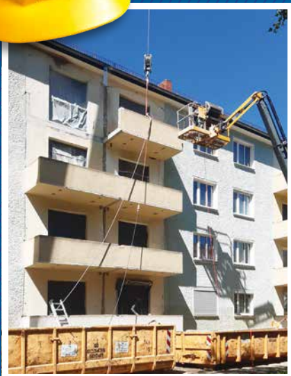
Rückbau der Balkone in der Leiblstraße 14–16.
