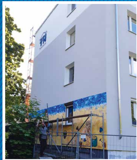
Restauriertes Giebelbild im Heidekampweg 93.
