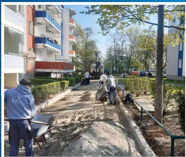
Wirtschaftsweg in der Kieholzstraße 148–149a wird neu angelegt.
