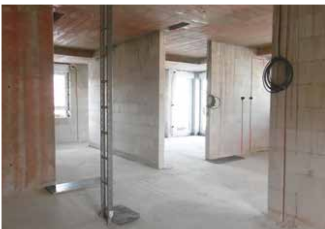
Wohnung im 4. OG des Rohbaus
