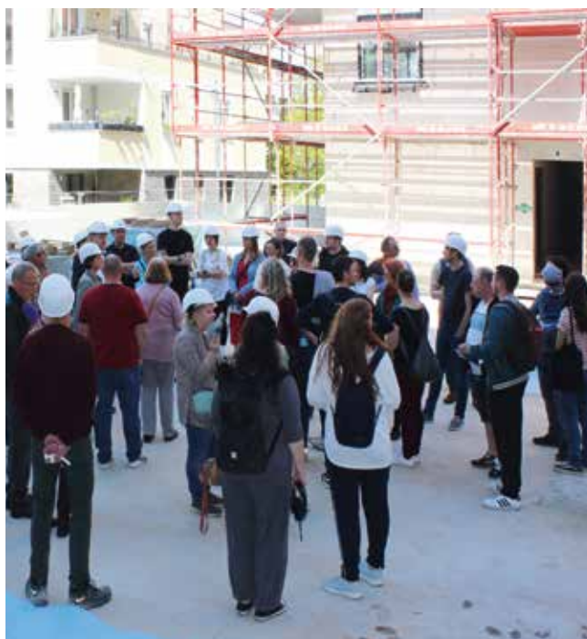
Baustellenbesichtigung unseres Neubaus EichbuschKarree
