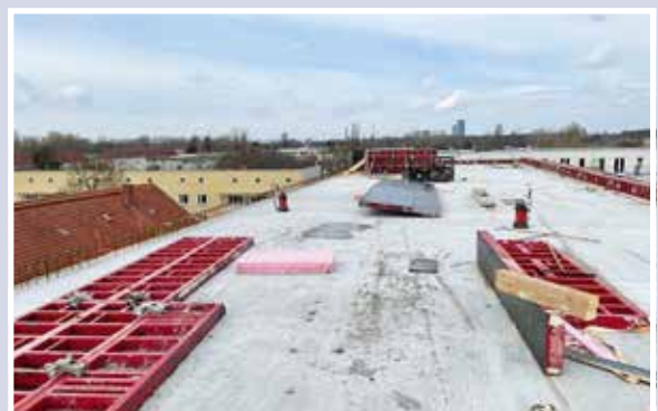
Blick auf das Dach Eichbuschallee 9F
