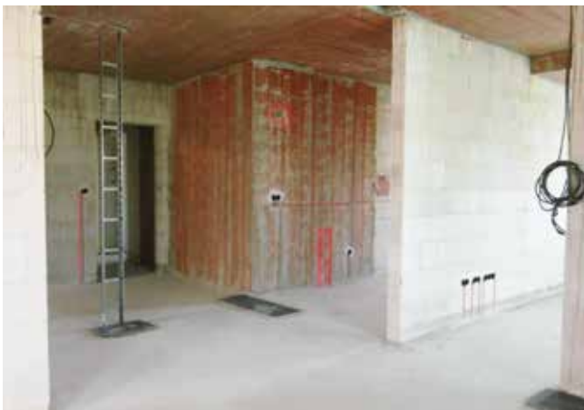
Wohnung im 4. OG des Rohbaus
