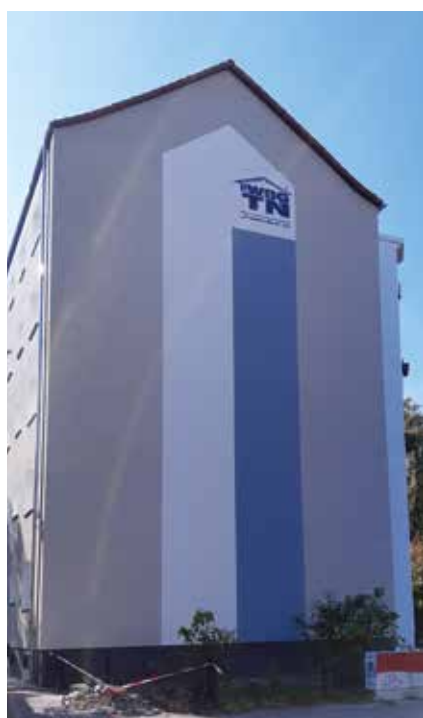
Giebelsanierung mit Wärmedämmverbundsystem Bouchéstraße 30
