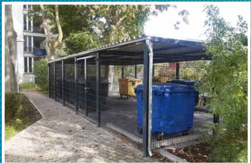
Überdachung des Müllstandplatzes in der Leiblstraße 17
