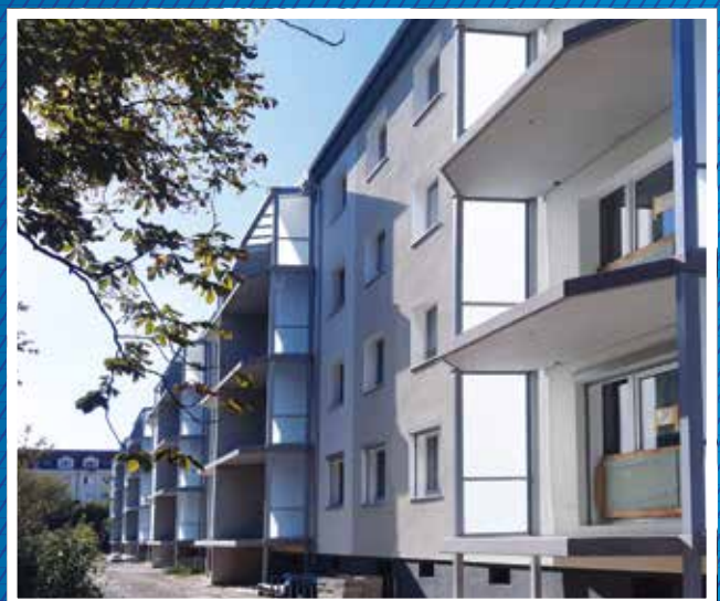
Balkonrohrmontage in der Frauenlobstraße 60–68
