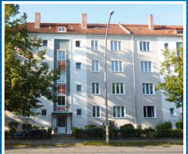
Sanierte Fassade in der Köpenicker Landstraße
