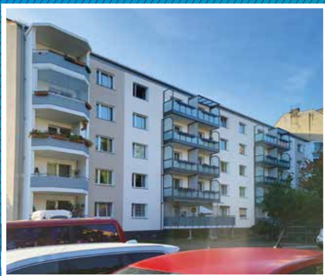
Neue Balkonanlagen in der Bouchéstraße 30–32
