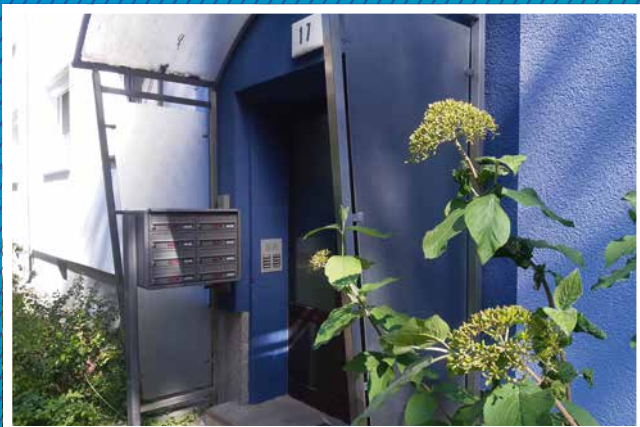
Neue Briekastenanlage Hänselstraße 15–21
