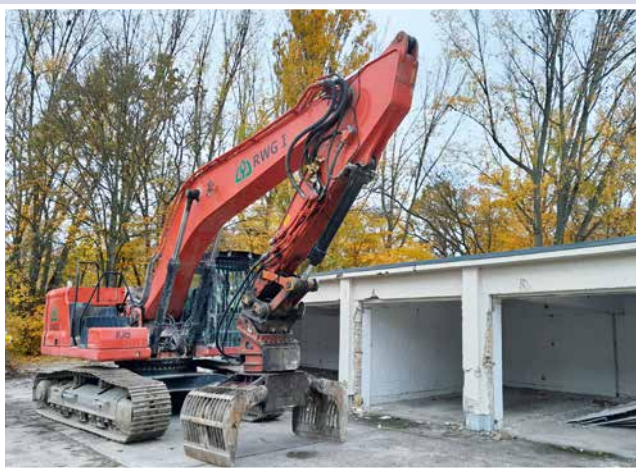
Rückbau der Garagen
