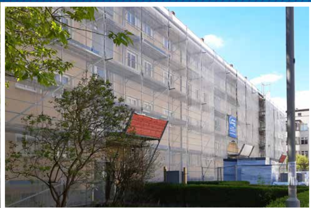
Gerüst für Fassadendämmarbeiten in der Frauenlobstraße 54–58
