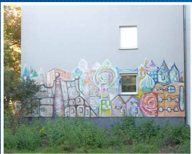
Wiederherstellung Wandbild Heidekampweg 139
