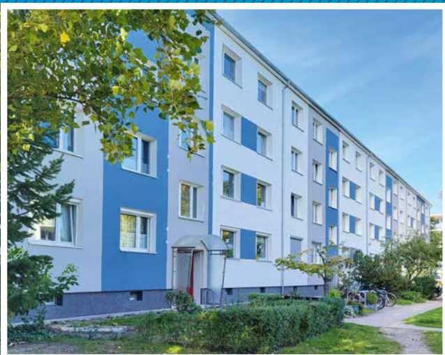
Hauseingangsseite Heidekampweg 125–131 nach der Sanierung
