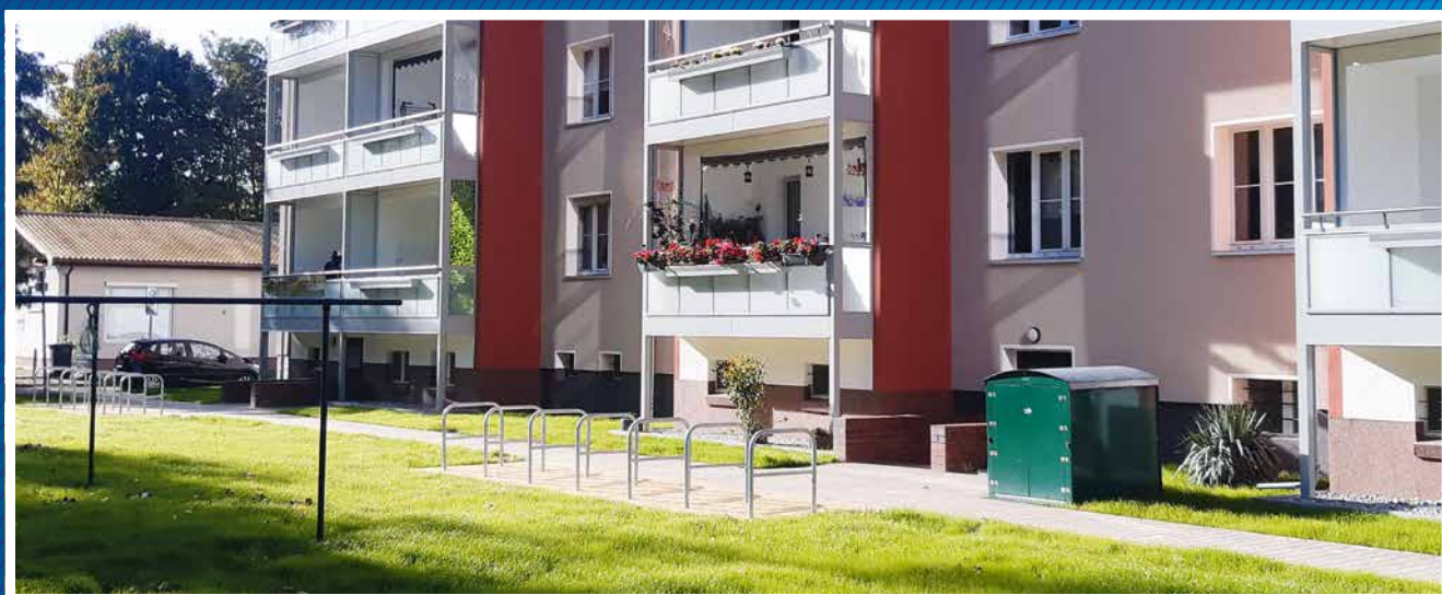
Neue Fahrradbügel Eichbuschallee 29–33 nach der Sanierung
