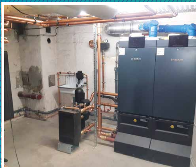
Heizungssanierung Heidelberger Straße 7
