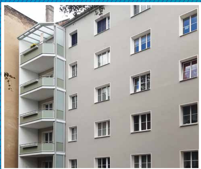
Neue Balkone Am Treptower Park 25
