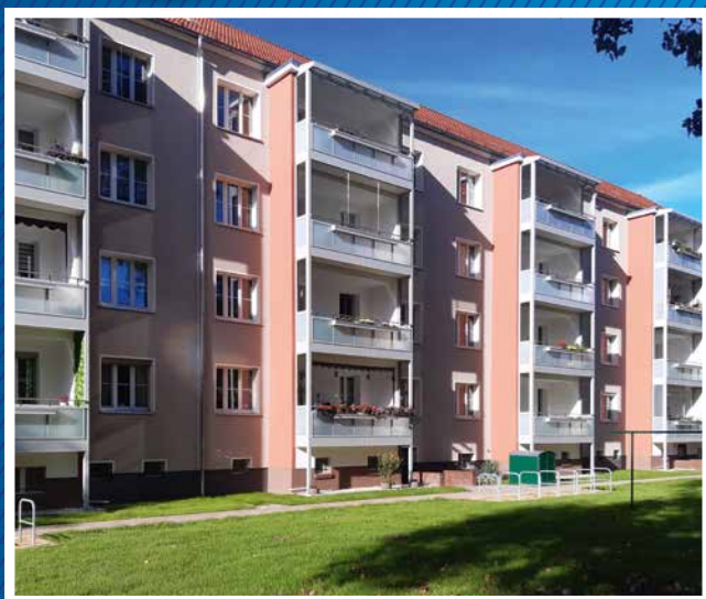
Balkone Eichbuschallee 29–33 nach der Sanierung
