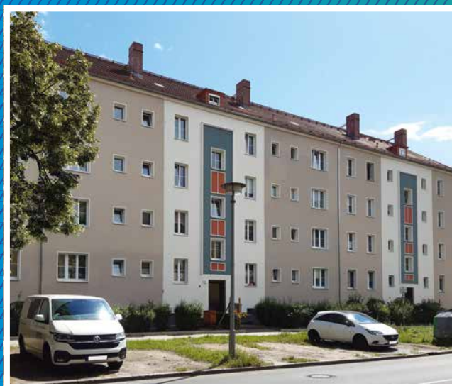
Hauseingangsseite Eichbuschallee 29–33 nach der Sanierung
