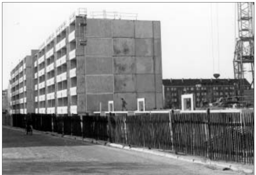
1975-77 errichtete Wohnhäuser des Bautyps WBS 70 am Schmollerplatz/ Heidelberger Straße
