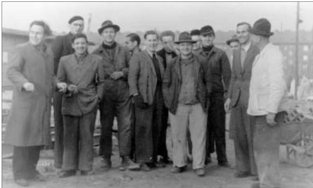
Arbeitseinsatz beim Bau der ersten Häuser in der Köpenicker Landstraße 1955
