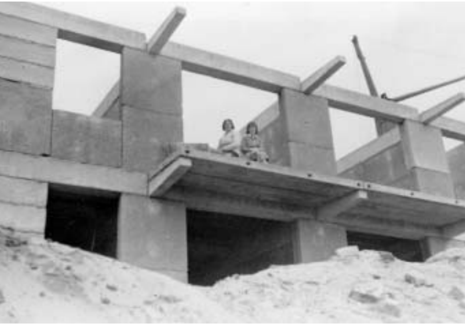
Q3A Block während der Bauphase
