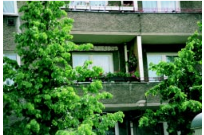
An den meisten Wohngebäuden konnte bis zur Wende selbst das grüne Umfeld die verschlissene Bausubstanz nur dürftig kaschieren.
