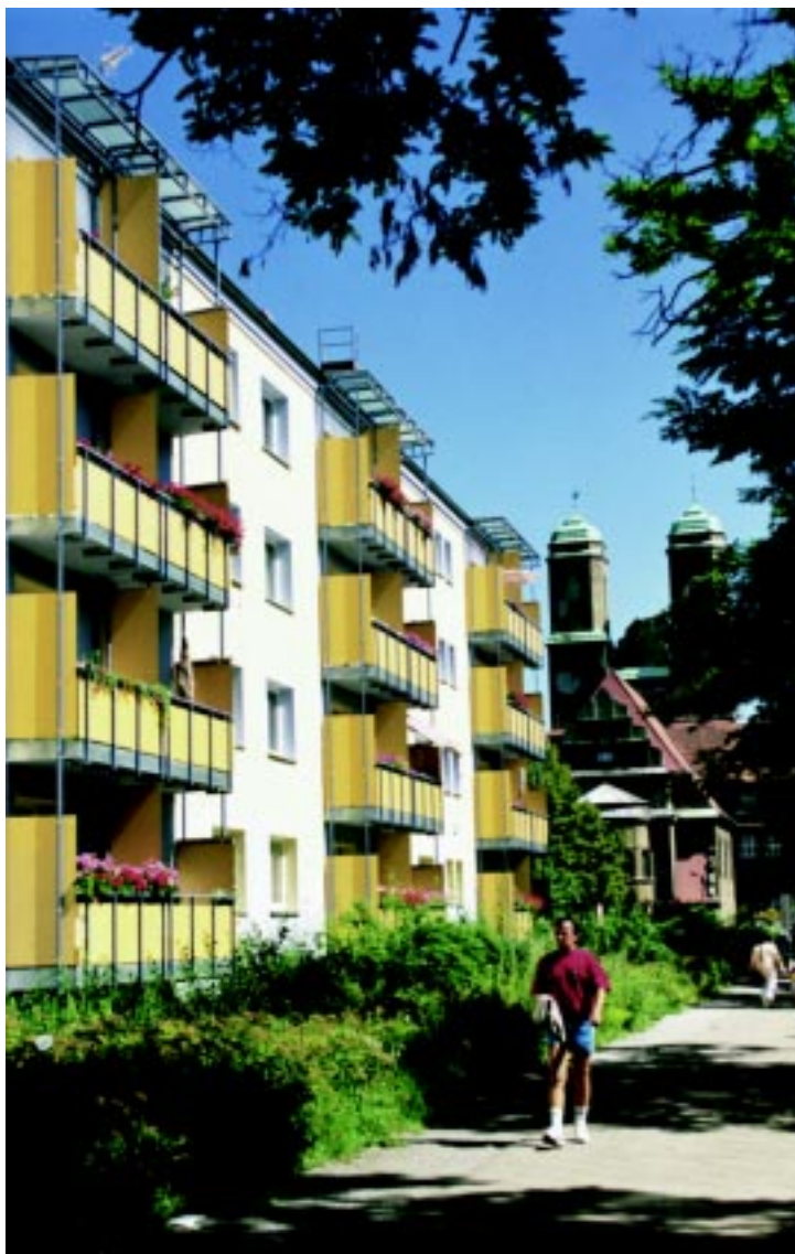
Die von der WBG „Treptow Nord“ rundum sanierten Wohnbauten wie hier in der Bodelschwingstraße in Baumschulenweg sind eine Referenz für genossenschaftlichen Aufschwung im Osten Berlins.
