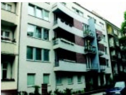
Der erster Neubau der WBG „Treptow Nord“ entstand 1996 in der Schradlerstraße (Baumschulenberg) mit 15 Wohnungen im 2. Förderweg.
