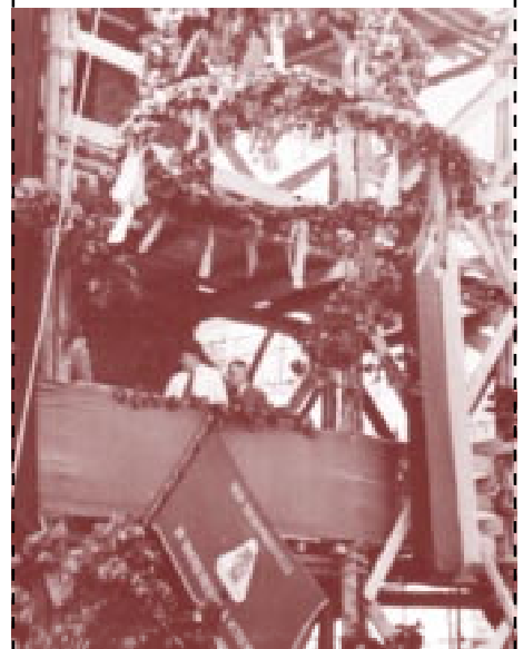
Richtfest am 9. September 1955 auf der AWG-Bau-stelle Am Treptower Park.
