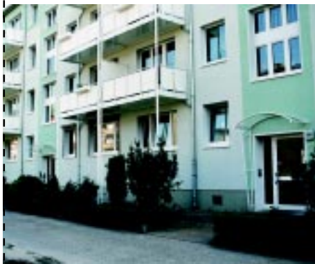
Sanierter Q3A-Block in der Erich-Lodemann-Strasse 105-113 (Plänterwald).
