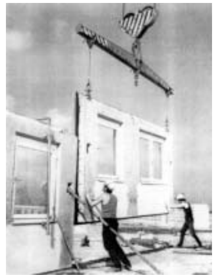
Montage einer Außenwandplatte der Wohnungsbauserie 70
