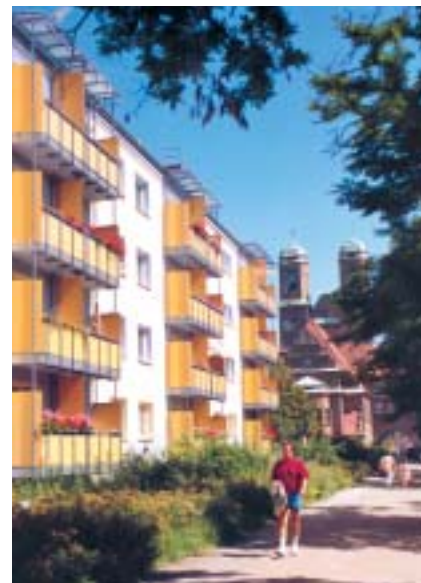
Sanierte Häuser in der Bodelschwinghstraße
