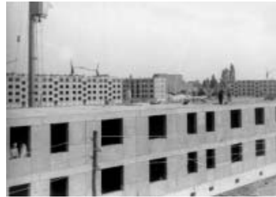
Q3A Bau im Bereich Kieffholzstraße
