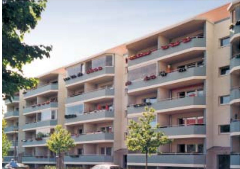
Neue Balkon- und Fassadengestaltung am Schmollerplatz
