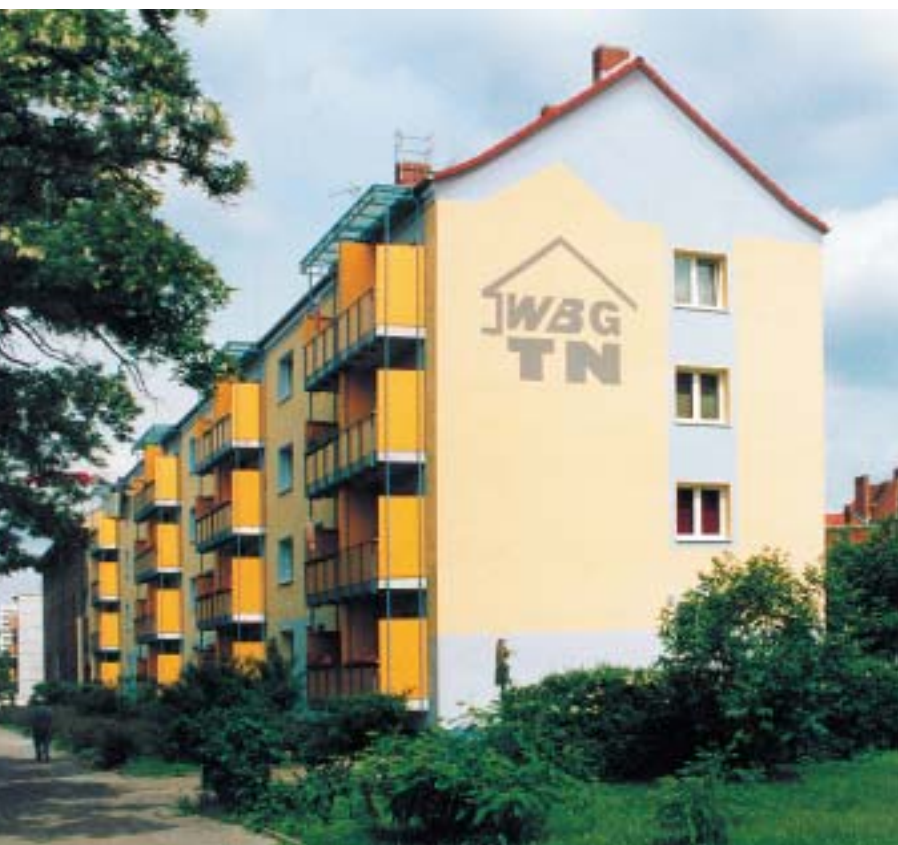
Sanierte Hausgruppen des Bautyps 57 in der Bodelschwingstraße
