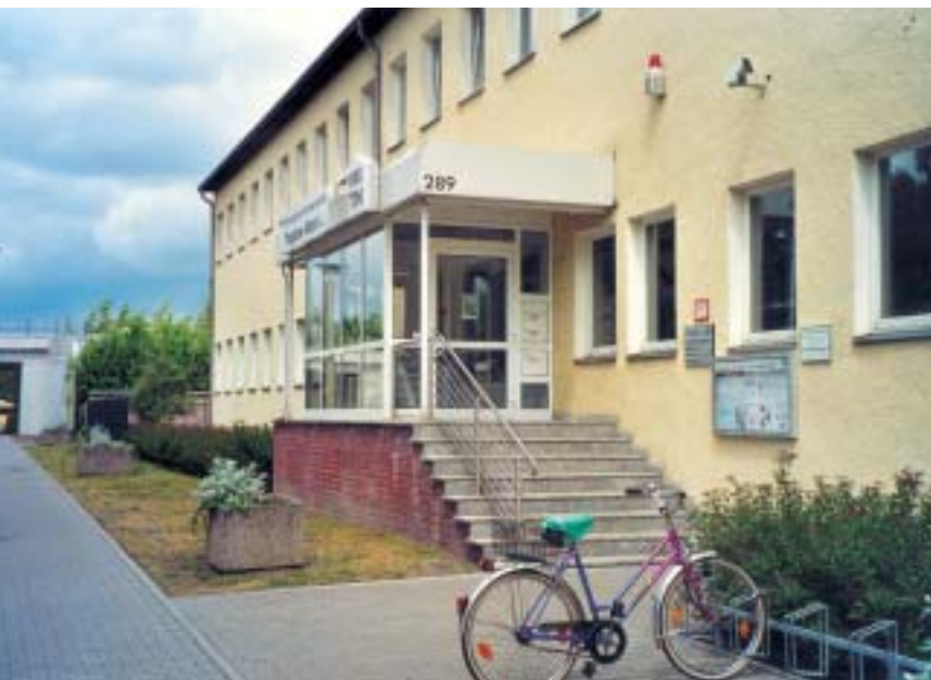
Die Geschäftsstelle der WBG »Treptow Nord« eG in der Kieffholzstraße 289
