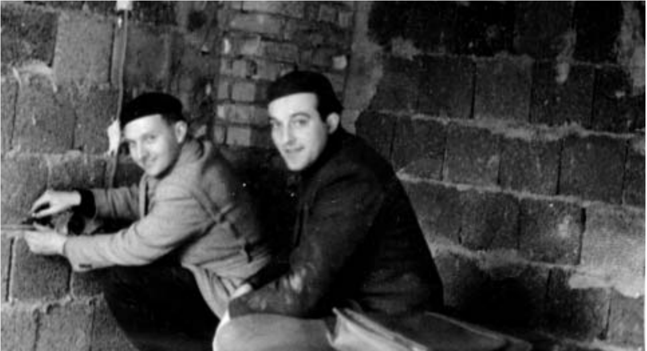
Mitglieder der Baukolonne im Wohnblock Heidelberger Straße
