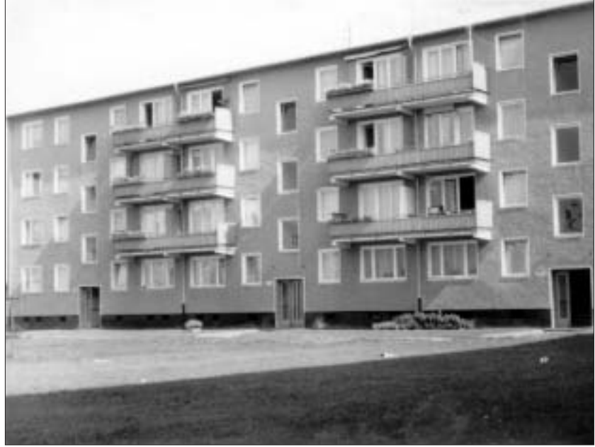
Q3A Bauten im Bereich Heidekampweg/ Kiefholzstraße
