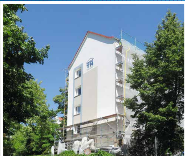
Giebel beim Abrüsten in der Bouchéstraße 25
