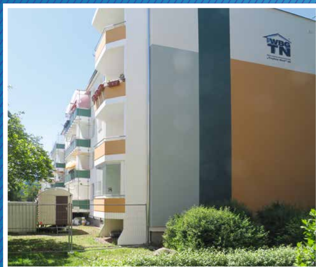
Neue Giebelansicht in der Hänselstraße 47–53
