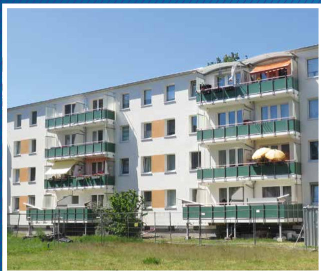
Neue Fassade in der Hänselstraße 47–53
