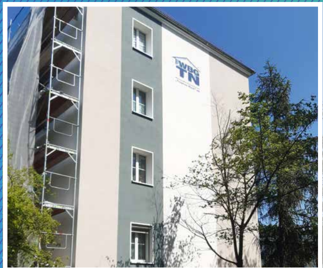
Fassadenarbeiten in der Eichbuschallee 21–25
