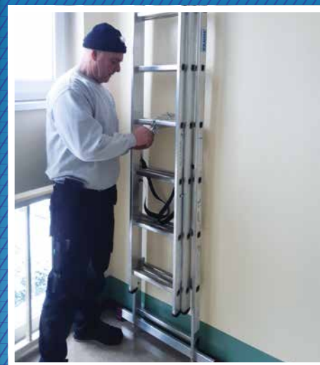
Montage und Erstprüfung einer gewerblichen Leiter im Q3A-Gebäude
