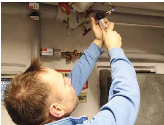
Abflammen der Wasserentnahmestelle
